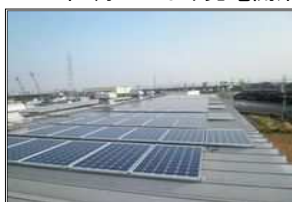
エアコンにルーフファン設置
