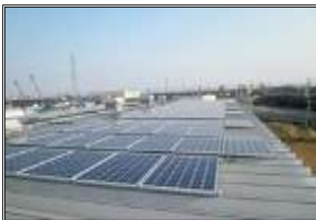
エアコンにルーフファン設置
